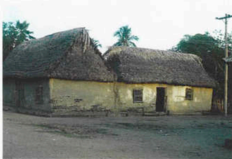
Photo N° 8 : Talsigua Viejo, Maison de Ramona Ruiz ( cantadora *), le 4 janvier 1996.
